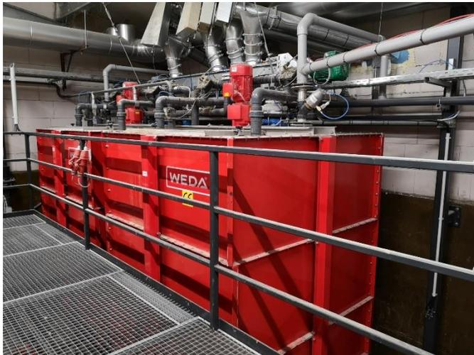
2x Anmisch Behälter 5,5 m<sup>3</sup> nur für Anmischen Flüssige Ferment. Diese AB pumpen Ferment in den 6 Fermentern
